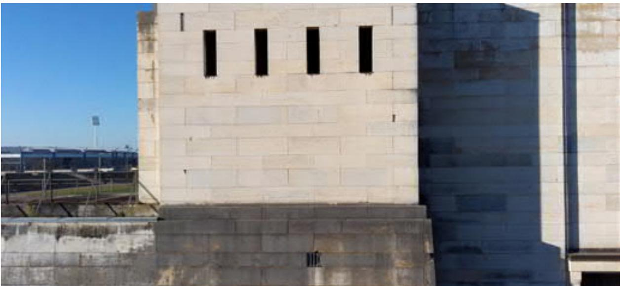
Hier sind die Beschädigungen in der Fassade gut zu erkennen. Oben die gut erhaltenen Kalksteine. Der Leuchtfaktor des Kalksteins ist immer noch vorhanden. Im unteren Bereich hat das in Jahrzehnten eingedrungene Wasser hingegen die Steine verfärbt und in der Substanz zerstört. Hinter der kleinen Öffnung müsste eine WC-Anlage (für Frauen) liegen.
